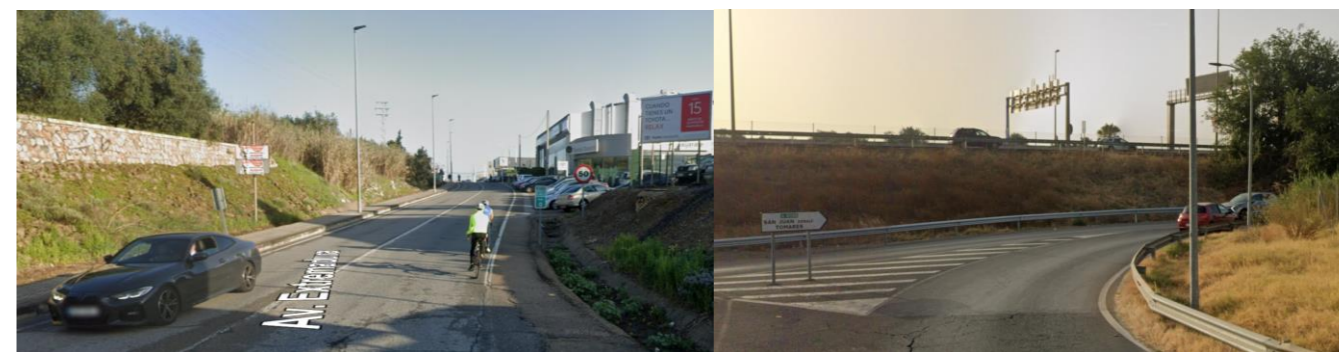
Acceso Norte. A-8078. Fuente: Google Earth
