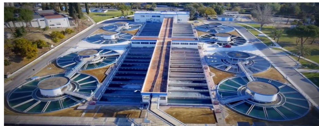
Centro de Depuración en Camas. Fuente: Emasesa
